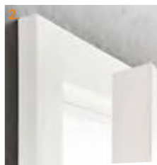
2. stumpfes Türblatt (ohne Türblattfalz)
