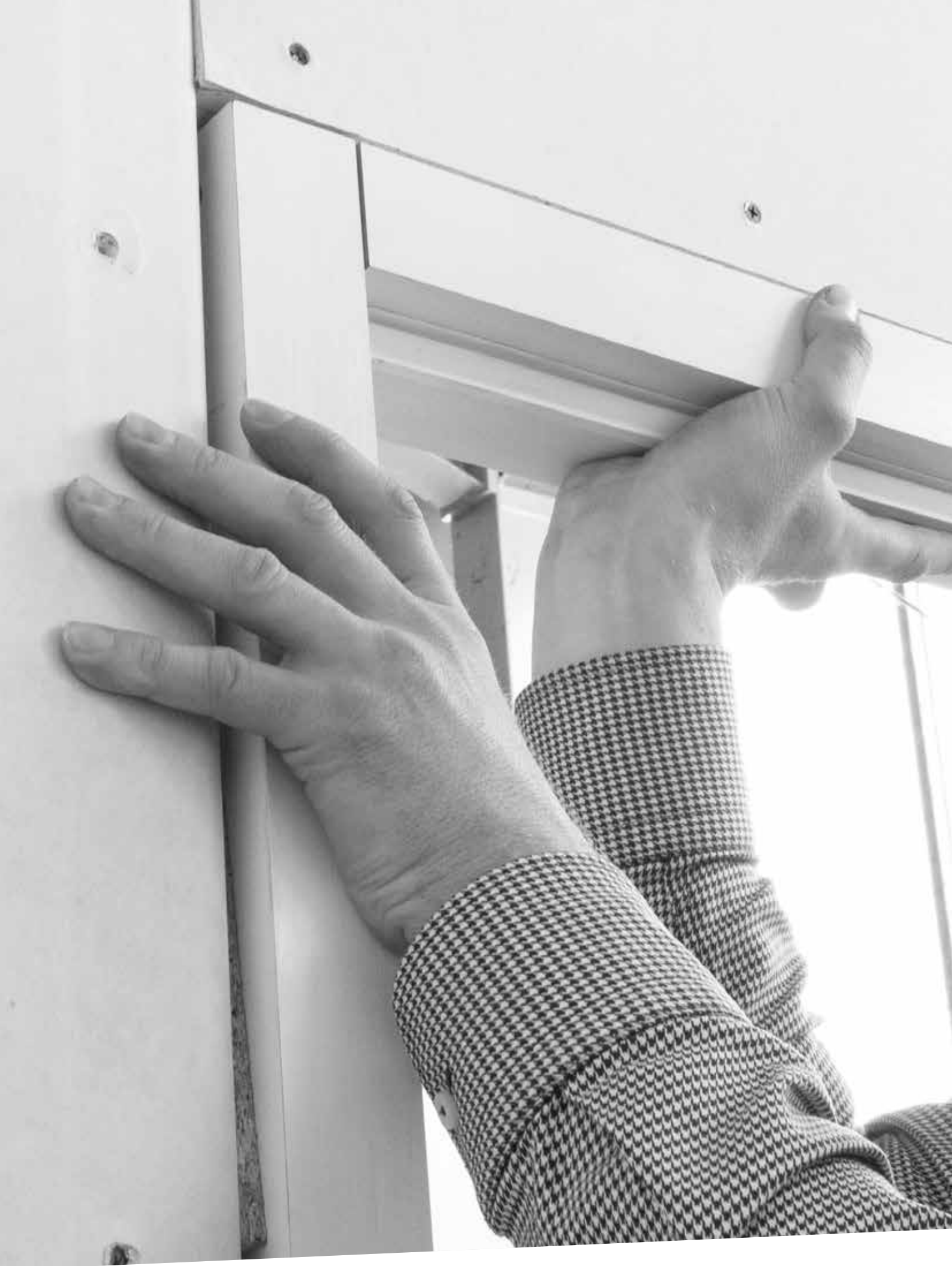
Die B-Zarge wird zwischen den Wänden befestigt und angeputzt.
