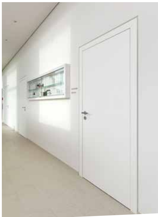
Schallschutzelement/ Soundproofing element Tür, Zarge und Wand flächenbündig, Schattennute umlaufend Flush door, frame and wall, shadow groove all around
