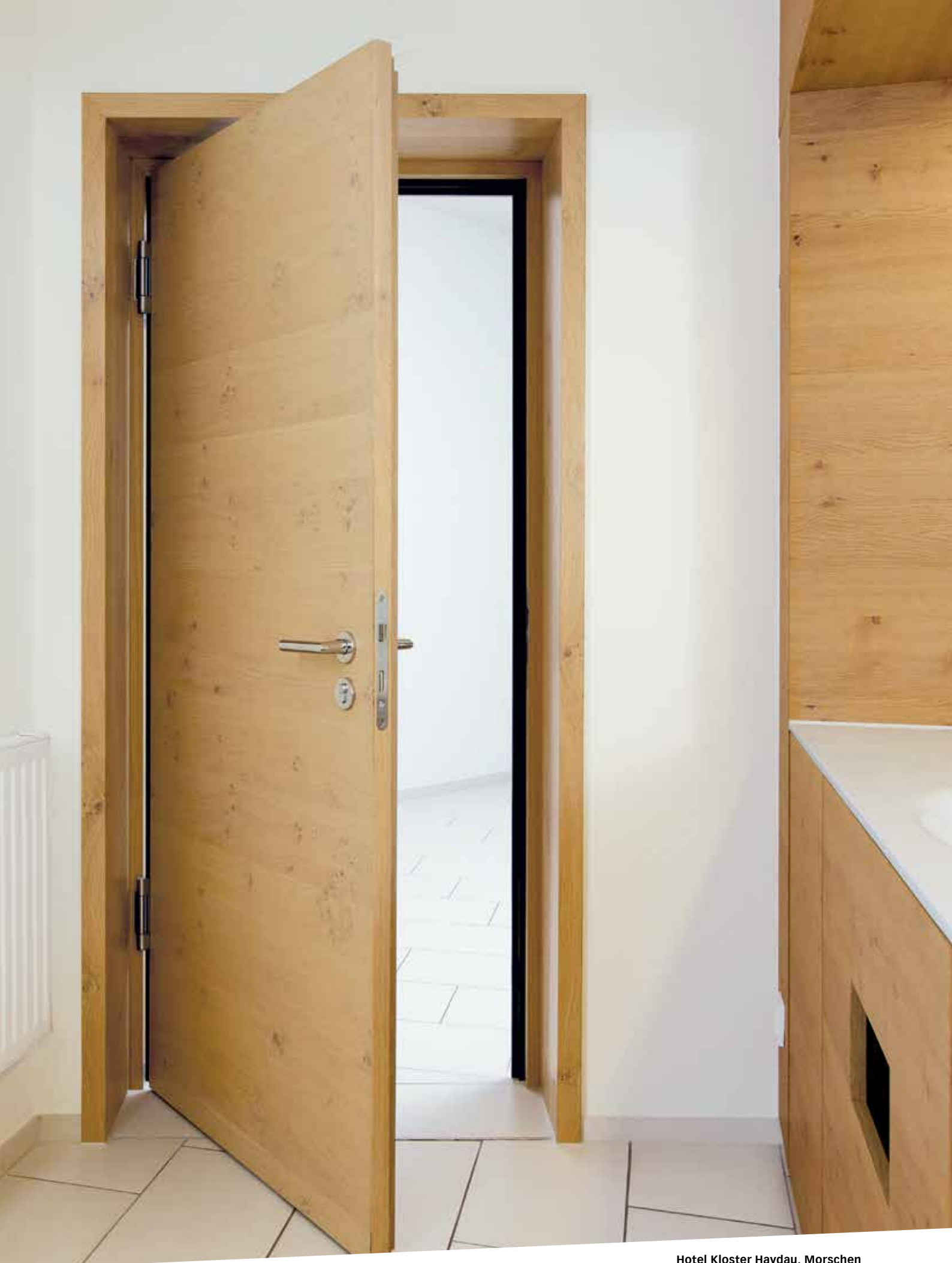
Hotel Kloster Haydau, Morschen Element mit Faltstockrahmen, in die Leibung öffnend Element with rebate frame, opening in the embrasure
